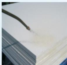
Nach ca. 30 Minuten Einwirkzeit können die Platten montiert werden. Die Oberfläche der Platten garantiert auch auf sehr glatten, ebenen Untergründen einen äußerst sicheren Haftverbund.
