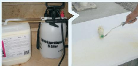
Nach dem Zuschnitt wird die dazugehörige Grundierung unverdünnt allseitig und auf alle Platten aufgetragen (mit Farbroller, Streichquast oder Sprühgerät), somit wird dem Plattenkleber nicht vorschnell das Anmachwasser entzogen.
