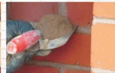
Fugensaniermörtel wird mit einer Spachtel aufgetragen
